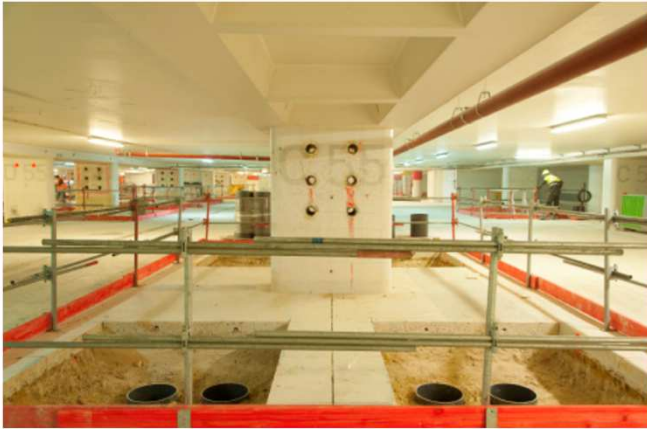
1.A) Micropiling preparation
